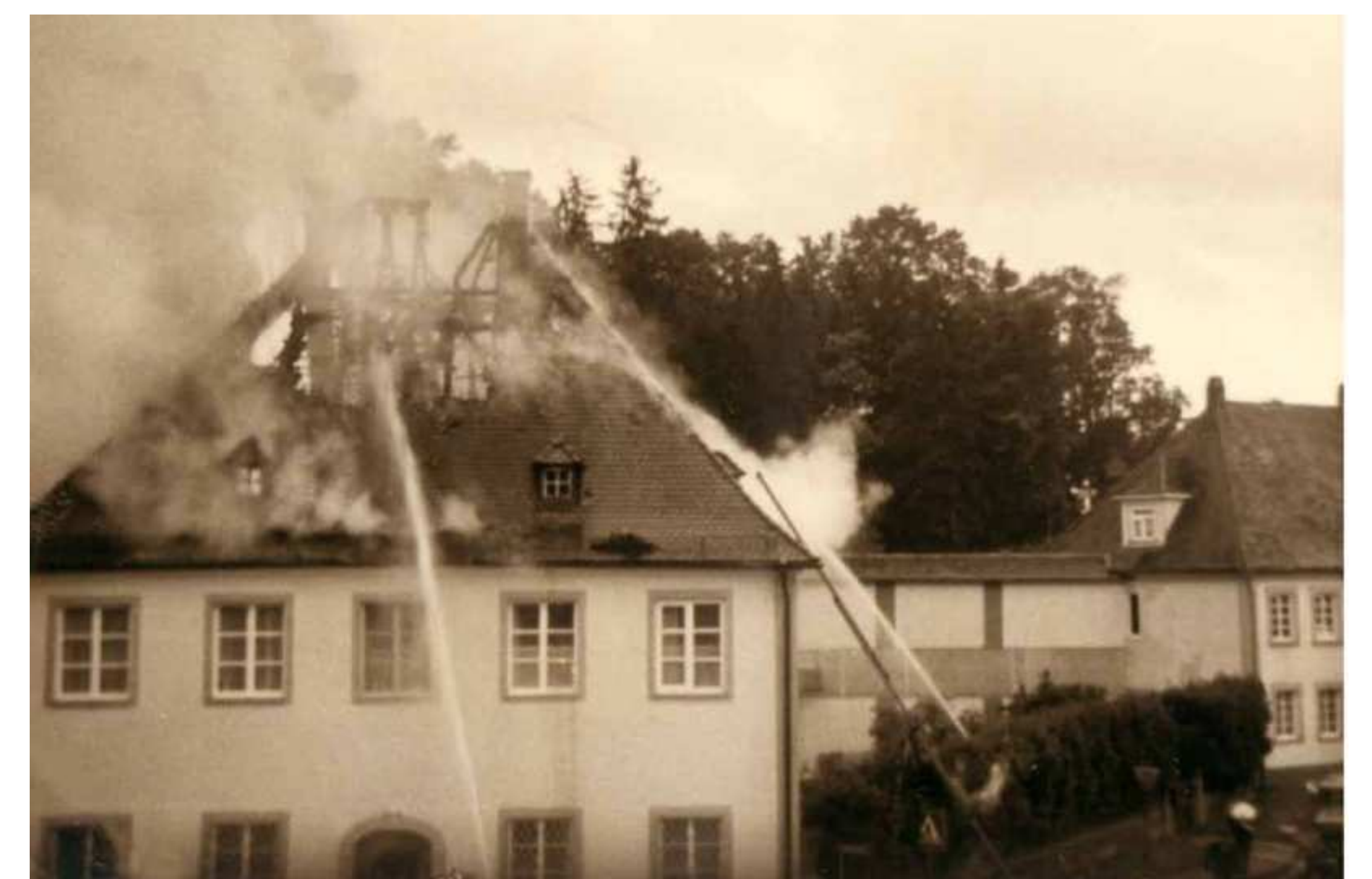
Der Dachstuhl wird komplett zerstört
